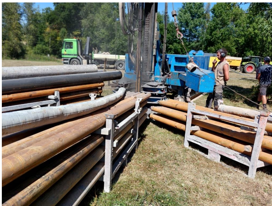
Photographie 1 : Exemple de plateforme foreuse / compresseur / stockage
